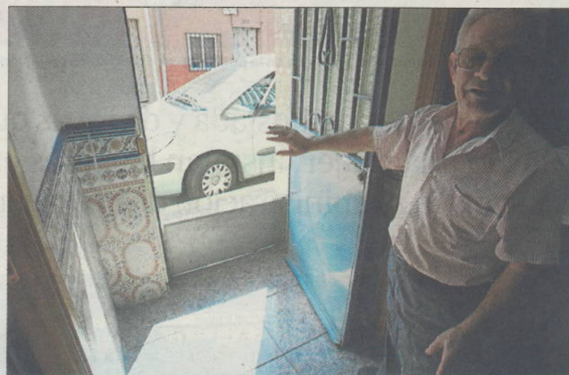
Algunos vecinos han colocado chapas de metal para repeler el agua. / A. CUÉLLAR
